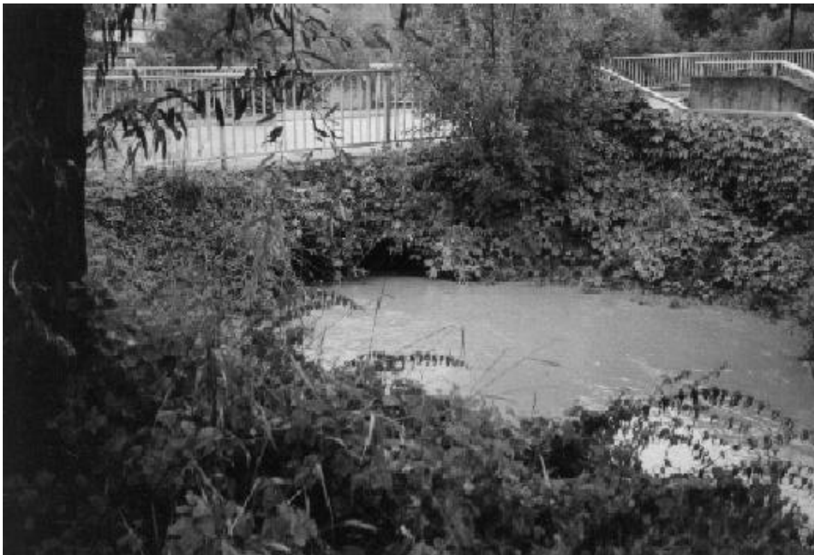
Bild: Hochwasser des Welzbaches von 2002 an der Unterführung "Im Hippel"
